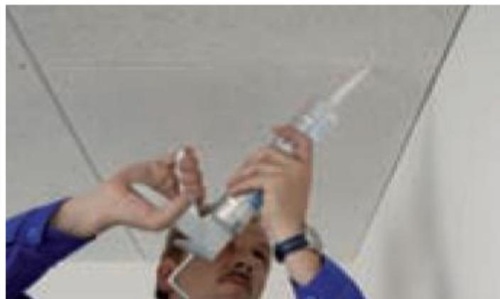
Швы плит Heradesign micro можно обработать акриловой смесью Knauf Dichtungsmasse. Затем окрасить силикатной краской
