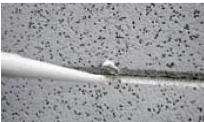
Сломанную кромку плит Heradesign micro или plano можно обработать акриловой шпаклевкой и покрасить после того как шпаклевка высохнет
