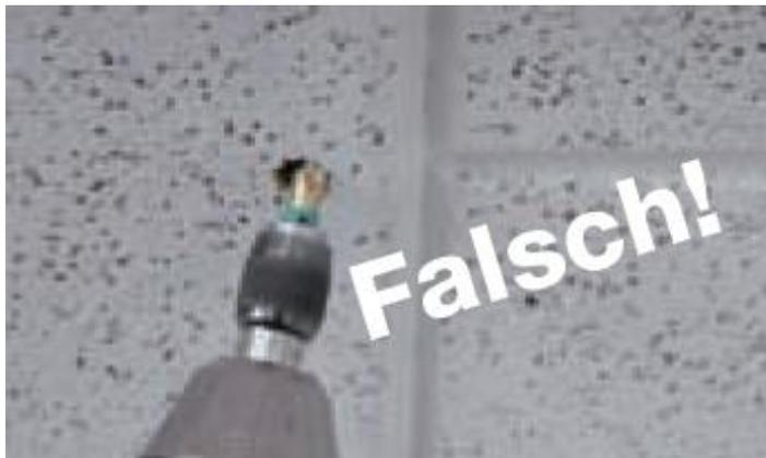
**Это неправильно!** Шляпка шурупа должна быть заподлицо с поверхностью плиты!
