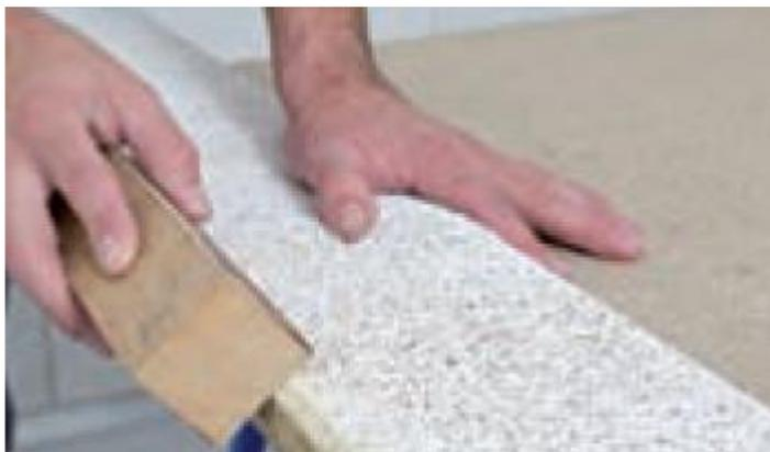
**Снятие фаски по торцу плиты:** выполняется с помощью крупной наждачной бумаги, абразивной ленты или отрезной фрезой
