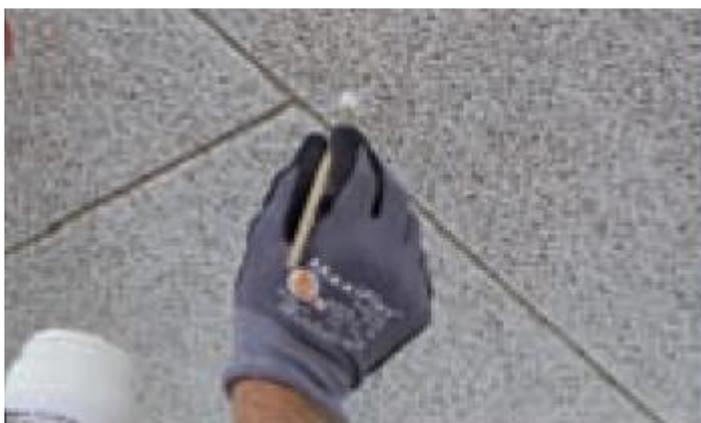
**Подкраска шляпок шурупов:** после монтажа закрасьте шляпку шурупа соответствующей краской тонкой кистью. При правильном монтаже шурупа шляпка не будет заметной. Не красьте плиту вокруг шляпки!
