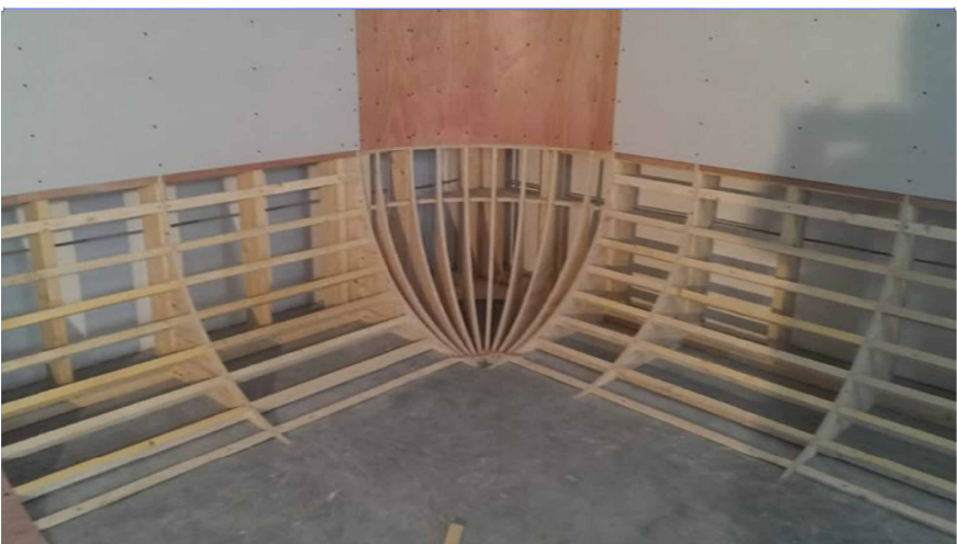
Вузол монтажу циклорами
