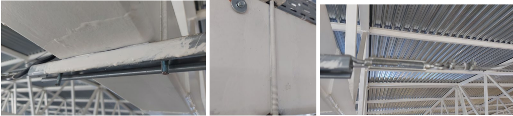
Рис. 3 – Кріплення тросу до ферм по осям 1, 6, 13, 20
