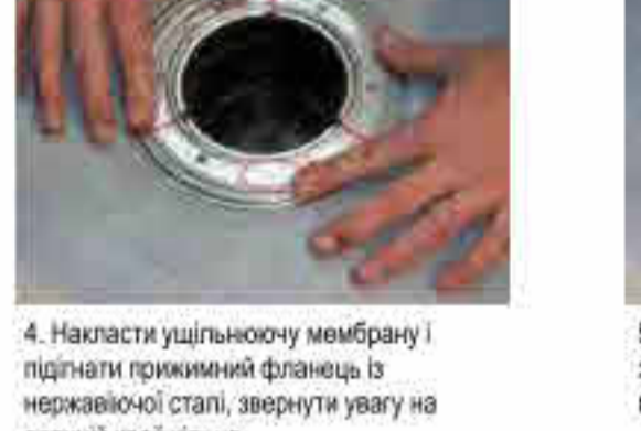
4. Накласти ущільнювачу мембрану і підняти примітний фланець із нержавіючої сталі, звернути увагу на верхній край кільця
