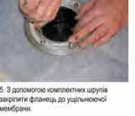
5. З допомогою комплектних шурупів закрити фланець до ущільнювачу мембрану.
