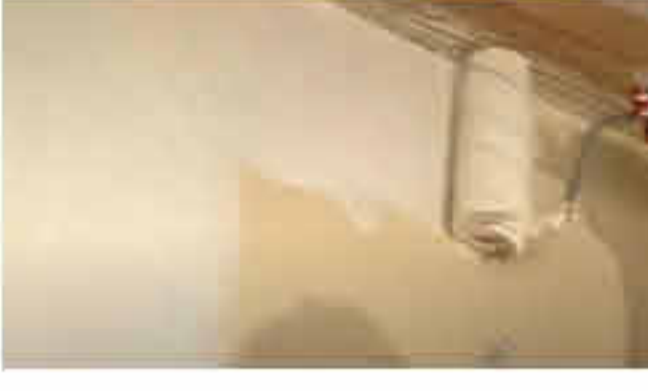
6. Нанести 2 шар гідроізоляції на всю площу приміщення.
