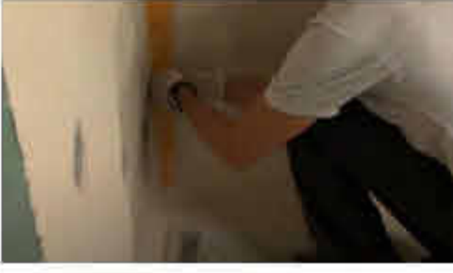
4. Накласти стрічку Sika SealTape S на шов стіни-стіни, з силою витиснути її в розчин.
