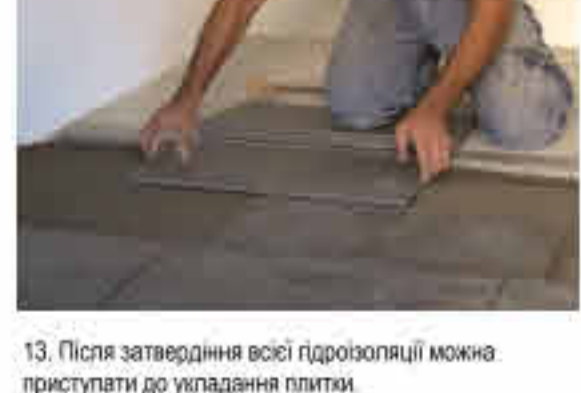
13. Після затвердіння всієї гідроізоляції можна приступати до укладання плитки.
