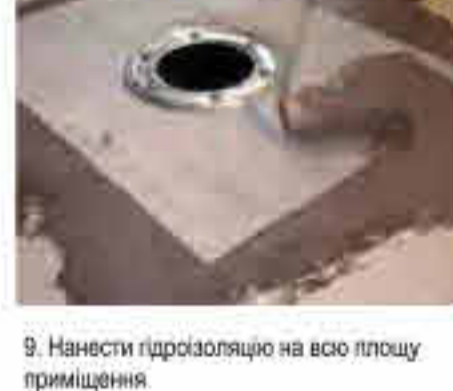
9. Нанести гідроізоляцію на всю площу приміщення
