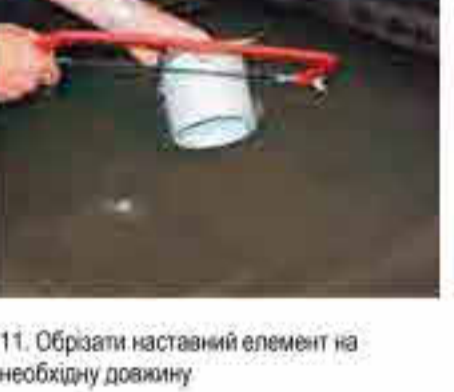
11. Обрізати наставний елемент на необхідну довжину
