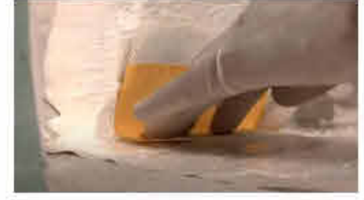
3. Накласти стрічку Sika SealTape S на шов підлого-стіни, з силою витиснути її в розчин.
