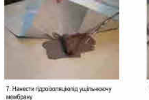
7. Нанести гідроізоляцію до ущільнювачу мембрану
