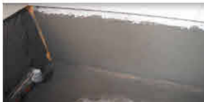
5. Нанести 2 шар гідроізоляції на всю площу приміщення.
