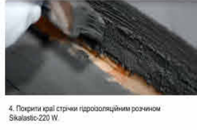
4. Покрити краї стрічки гідроізоляційним розчином SKALASTIC-220 W.
