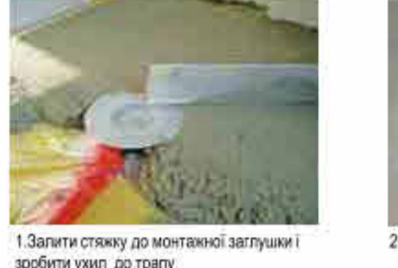
1. Заграти стяжку до монтажної заглибки і зробити ухіл до трапу
