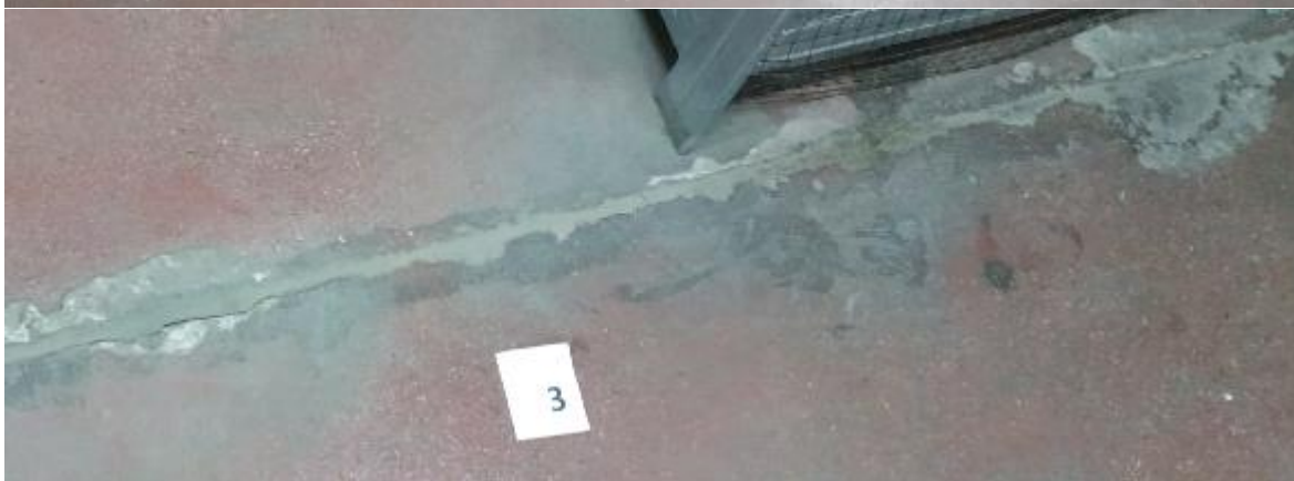
Фото пошкоджень підлоги секціях №3(зона поличного зберігання)
