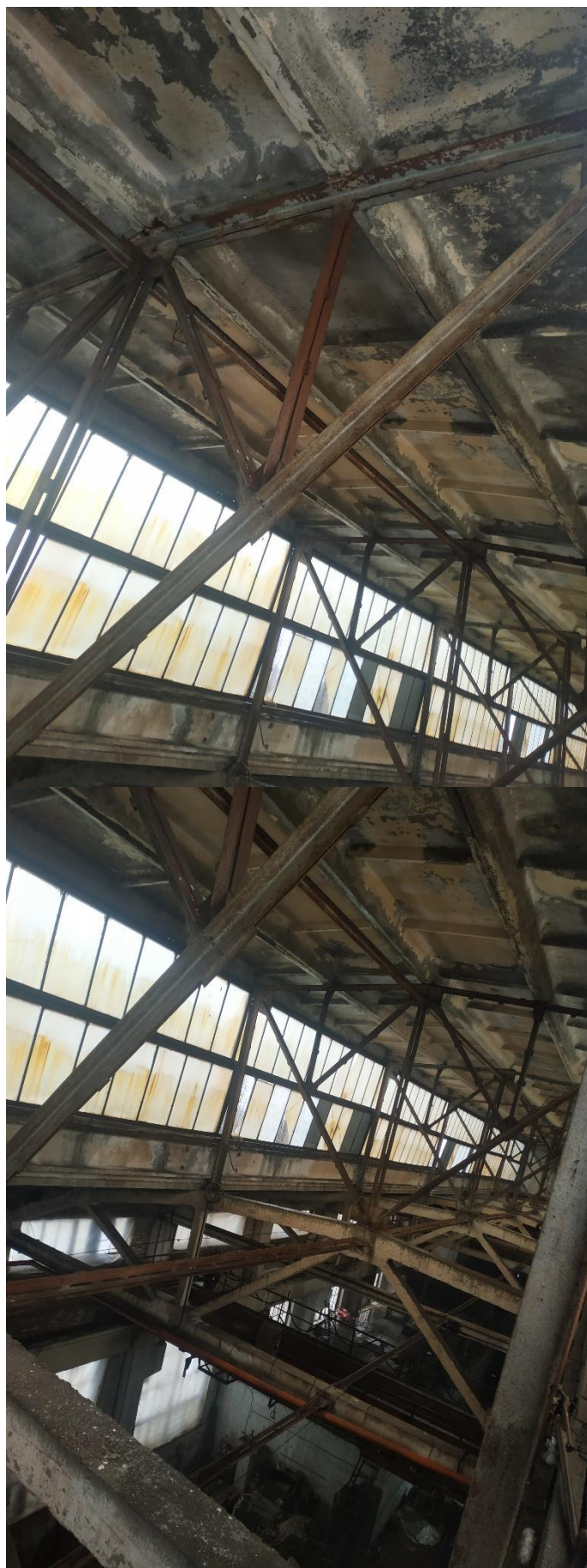
2.1.6 Демонтаж железобетонных стеновых панелей низа фонаря. Опускание на землю в цех.
