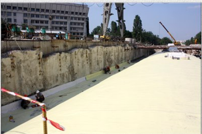
Тоннель, станция метро «Васильковская»
