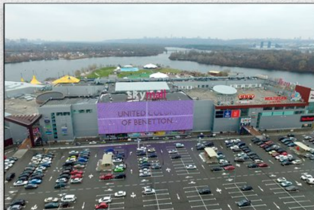
ТРЦ «Sky mall» г. Киев, ул. Генерала Ватутина
