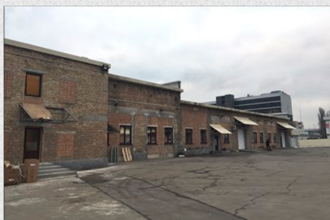
Складские помещения г. Киев, ул. Хвойки
