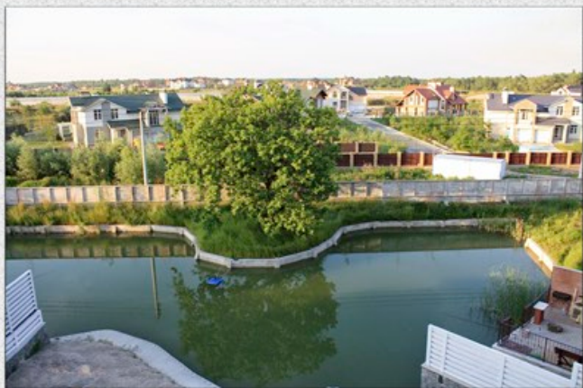
Генподрядчик: частный заказчик - 2009 г. Киевская обл., с. Плюты (680 м.кв.)
