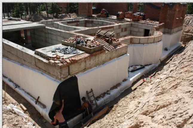
Фундамент коттеджа, с. Хлебча
