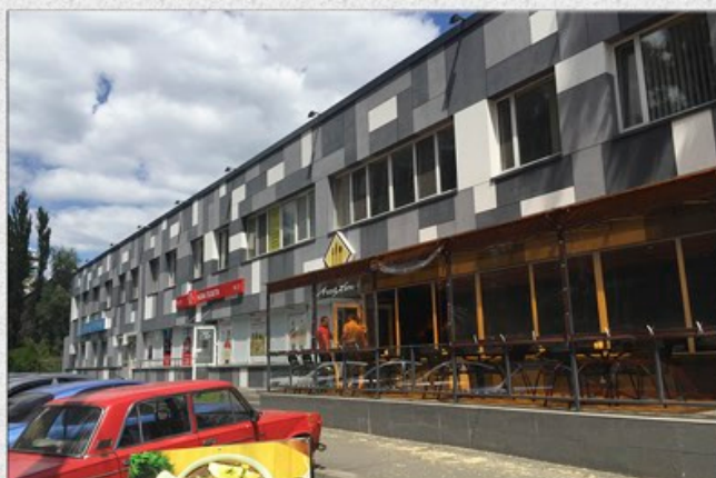
Офисный центр г. Киев, ул. Семьи Сосниных
