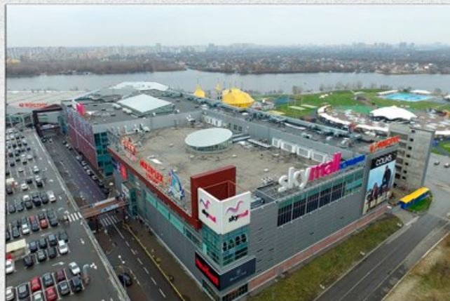
ТРК «Sky mall» г. Киев, ул. Генерала Ватутина
