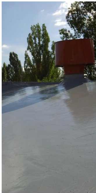
Гидроизоляция кровли полимоочевиной.
