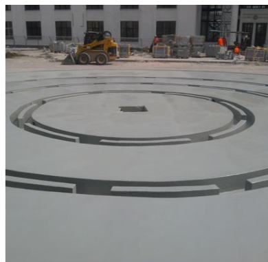
Гидроизоляция полимоочевиной фонтанов и бассейнов.
