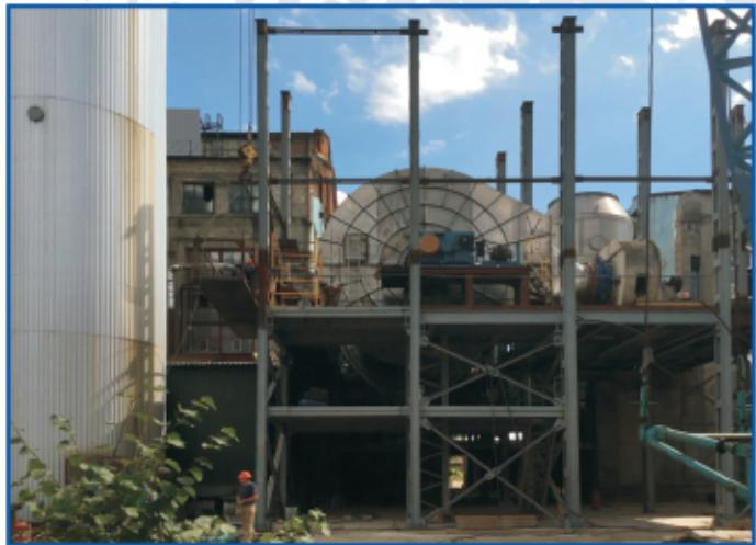
Параллельно велись работы по монтажу металлоконструкций, пресскамерных фильтров на ОДО "Новоивановский сахарный завод"; на "Глобинском сахарном заводе" производили монтаж жомопрессов, монтаж металлоконструкций и пресскамерных фильтров.
