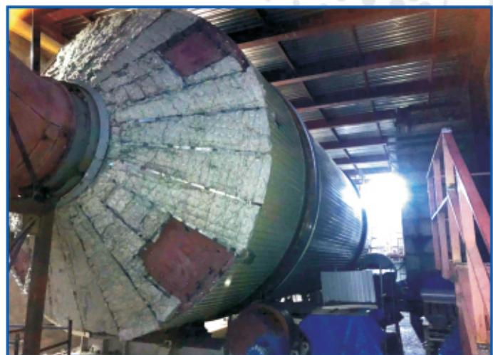
На ПАО "Каневсксахар" применена смонтирована жомосушильная установка производства ООО "НПО "Дондеталь". Оптимальный показатель расхода газа достигается благодаря применению новой запатентованной технологической схеме с внедрением современных систем автоматизации. ООО "ПМУ "Сахавтомат" является официальным представителем ООО "НПО "Дондеталь" по продаже и гарантийному обслуживанию трехходовых жомосушильных установок на территории Украины.
