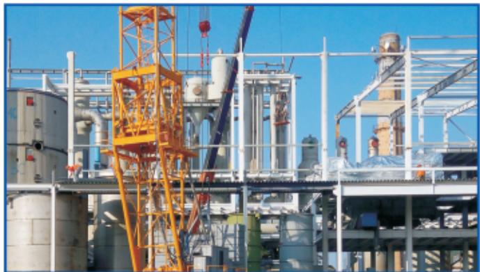
В 2014 году компания окончила строительство нового сахарного завода по переработке сахара сырца мощностью 1500 тонн сахара в сутки, республика Узбекистан. Было выполнено: монтаж основного технологического оборудования, изготовление и монтаж технологического оборудования по рабочей документации заказчика, изготовление и монтаж металлоконструкций, монтаж оборудования АСУ ТП. Начало работ - май 2013 окончание июль 2014 год.
