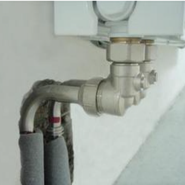
Влаштувати підключення всіх радіаторів зі стіни
