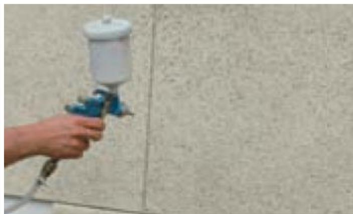
При необходимости произведите перекраску поверхности плиты с помощью пульверизатора
