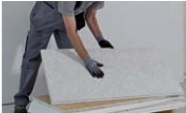
Визуально проверьте целостность плиты. При необходимости удалите чистой щеткой пыль с поверхности плиты
