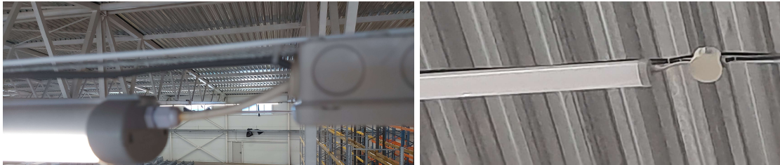
Рис. 1 – Світильник з розподільчою коробкою
