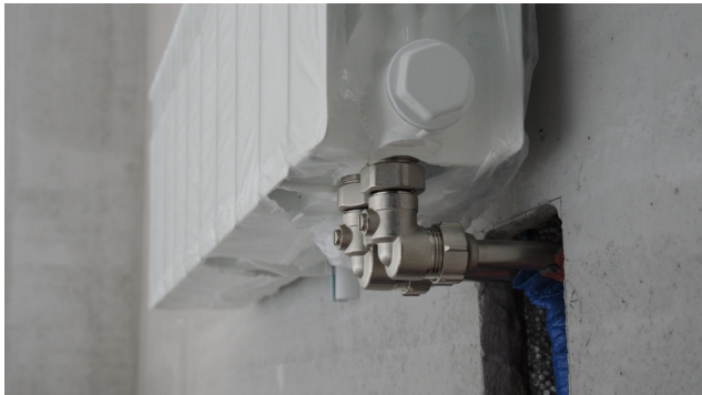
Підведення радіатора виконати через стіну, як зазначено на зображенні
