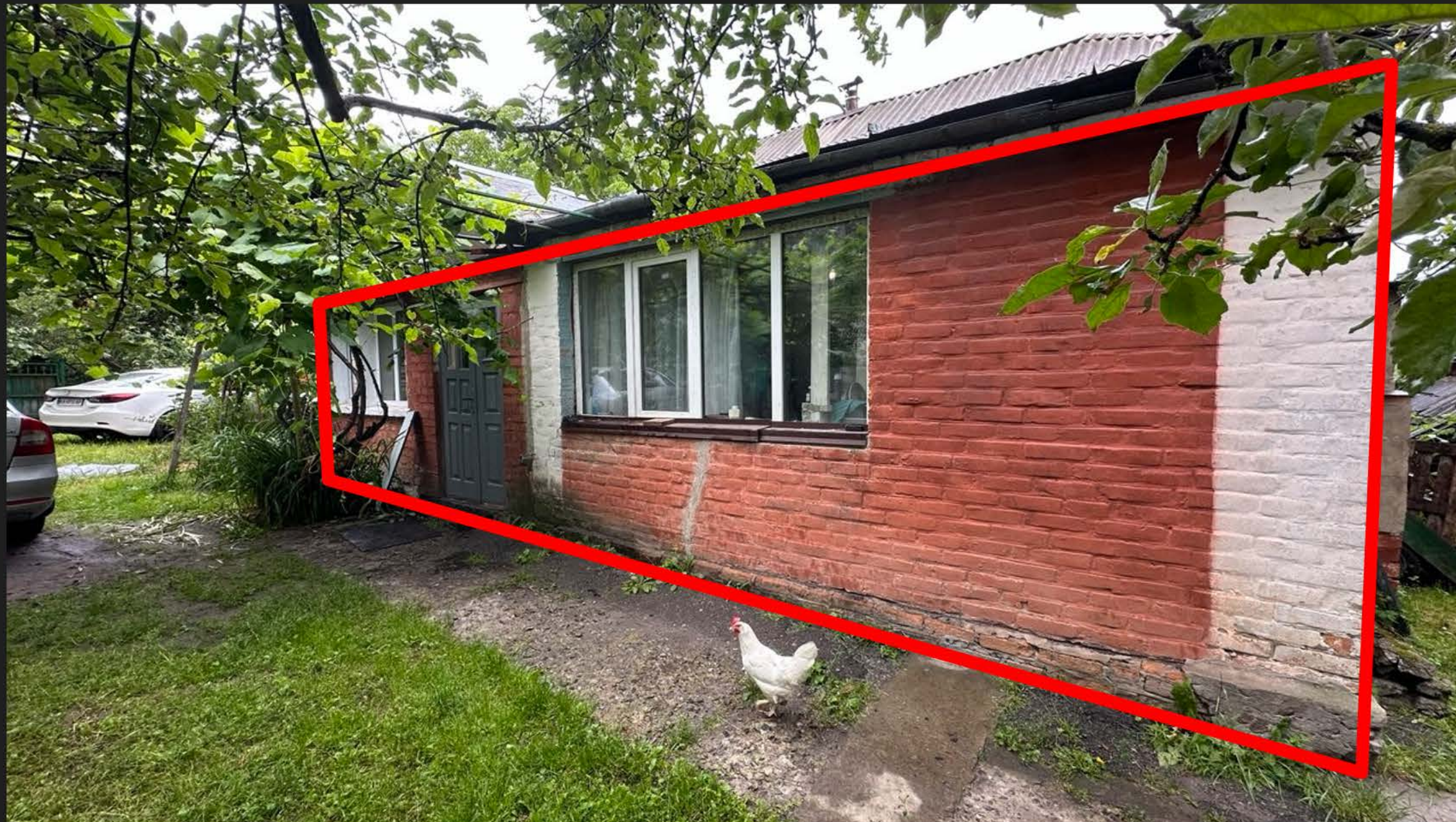
Утеплення фасаду. Фото № 3.
