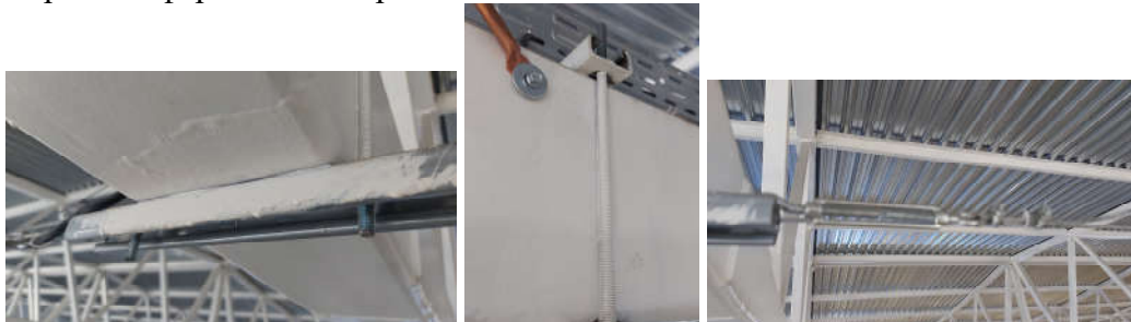
Кріплення тросу до ферм
