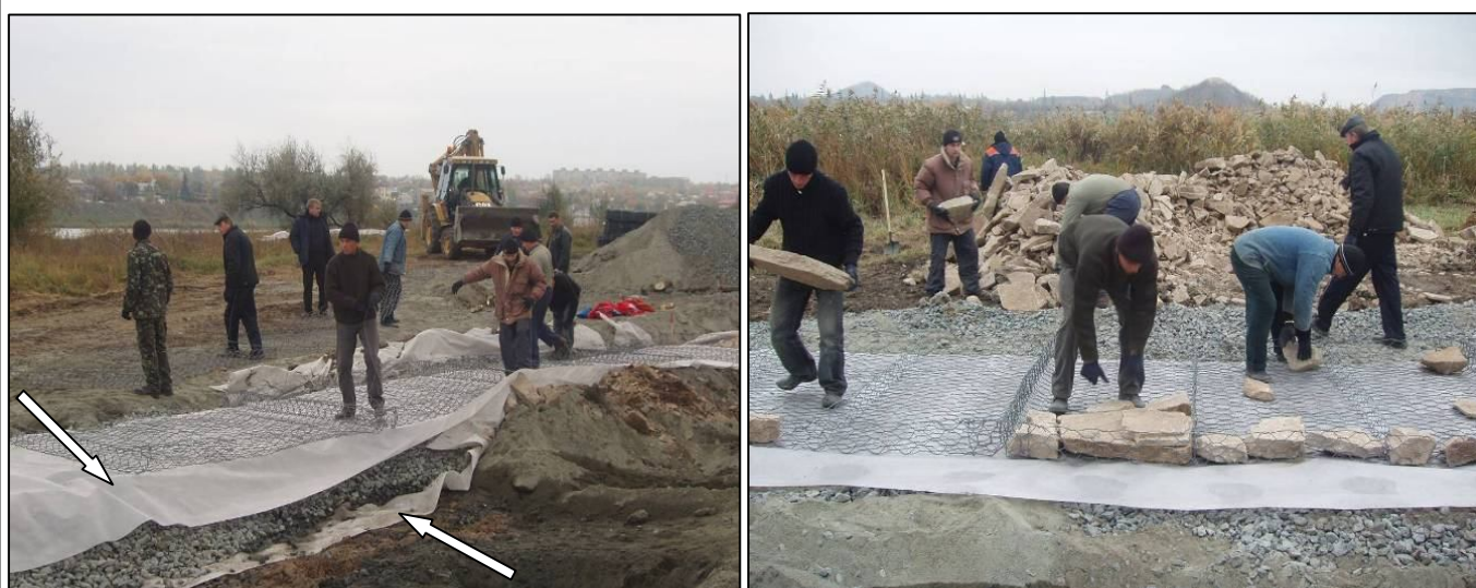
Рисунок. 1 Приклад влаштування щебеневої подушки під габіони
