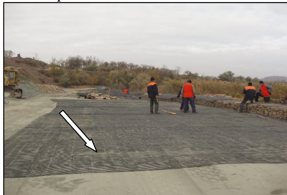
Рисунок 15 Вкладання полотен геораток між рядами габіонів.
