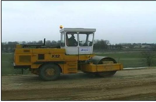
Рисунок 13 Ущільнення матеріалу зворотної засипки
