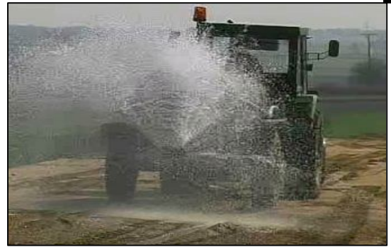
Рисунок 13 Ущільнення матеріалу зворотної засипки
