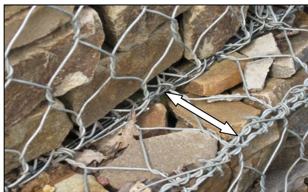
Рисунок 12 Приклад поступового зміщення рядів габіонів
