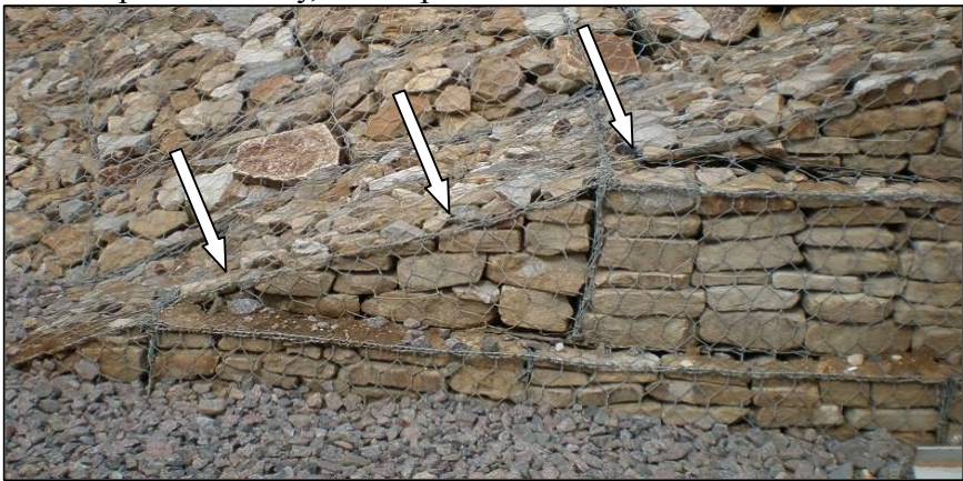
Рисунок 19 Приклад підрізки габіону по діагоналі.
