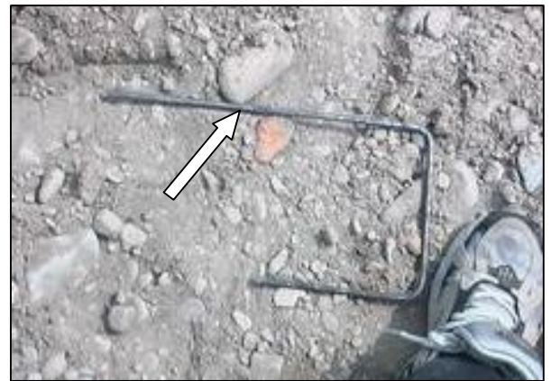
Рисунок 16 Напуск геораток та варіант металевого нагелю.
