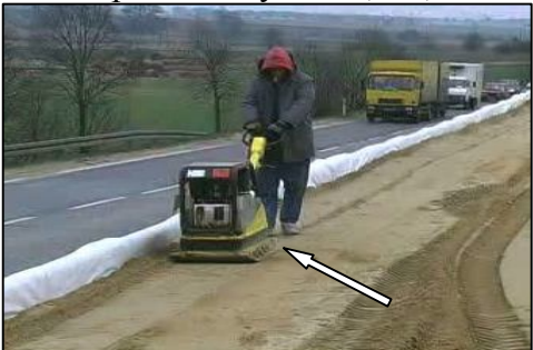
Рисунок 18 Доущільнення ґрунту ручними віброплитами.
