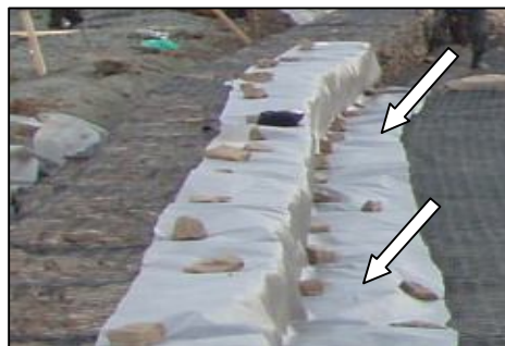
Рисунок 11 Вкладання зворотнього фільтру.
