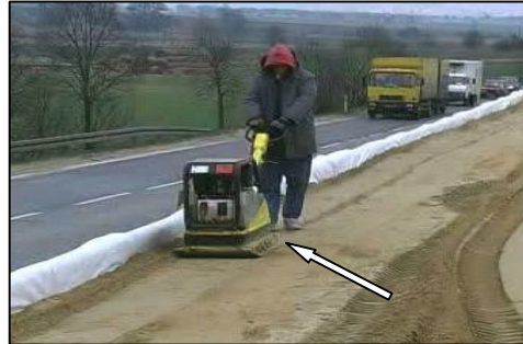
Рисунок 14 Доущільнення ґрунту ручними віброплитами.
