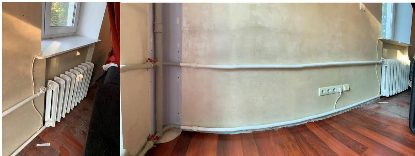
3. Сделать новую разводку труб для радиатора отопления на балконе, как указано на рисунке (сквозь стену). Установить по центру балкона 10 секц. алюминиевый радиатор. ( Балкон будут утеплять и выравниваться пол в один уровень с комнатой).
