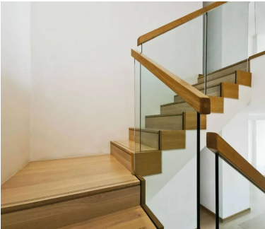
Приклади можливого кріплення огорожі:
