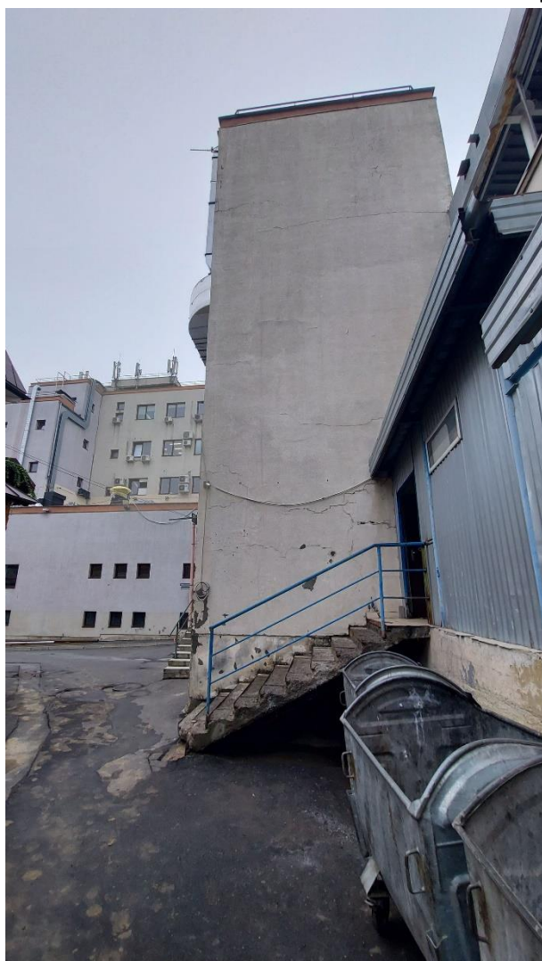
Фотозвіт з місця проведення ремонтних робіт.
