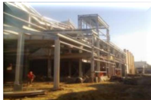
«ЦЕНТРАЛЬНАЯ ПРОМБАЗА» Помещение производства металлических изделий г. Полтава
